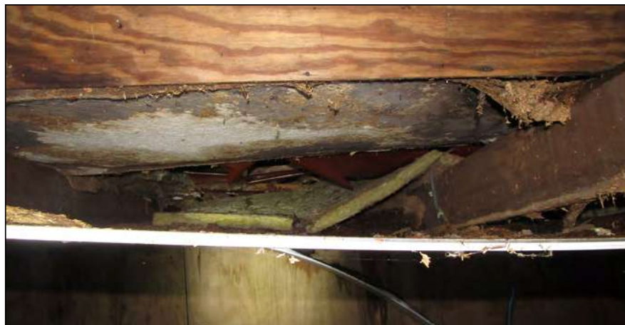
Figuur: achter het dakbeschot is oud isolatiemateriaal aanwezig, waardoor het microklimaat stabiel en droger is. Dit maakt geschikt als verblijfplaats voor marters, maar bijvoorbeeld ook vleermuizen.
