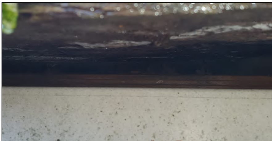
Figuur: tussen het dakbeschoot (onder) en de dakbedekking (boven) van het hoofdgebouw is voldoende ruimte aanwezig voor vleermuizen om tussen te kruipen en verblijven.
