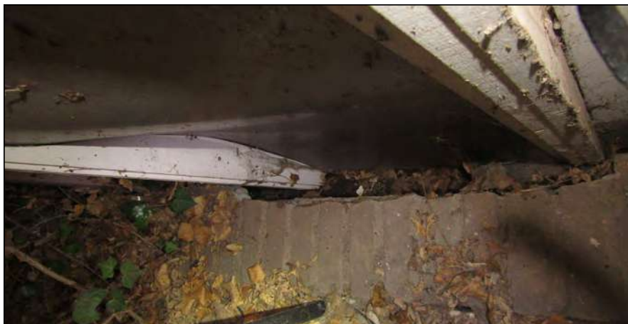
Figuur: in het smalle zijgebouw (een voormalige speelmuur) is een kruipruimte aanwezig waar marters gebruik van kunnen maken.
