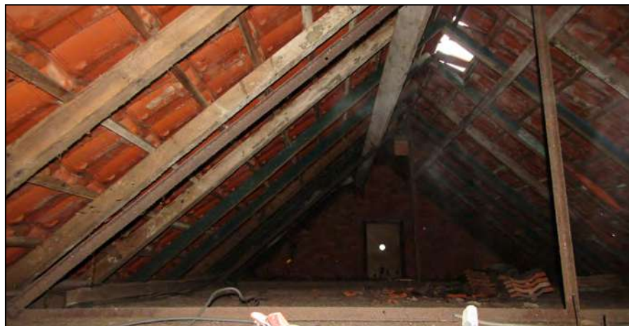
Figuur: het kleine schuurtje met dakpannen heeft een grote open zolder. Vleermuizen kunnen er verblijven in spleten achter de spanten. Ook marters kunnen hier verblijven.
