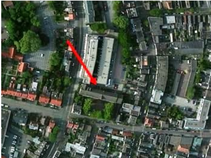
Luchtfoto locatie Nieuwstraat 35 en 37
