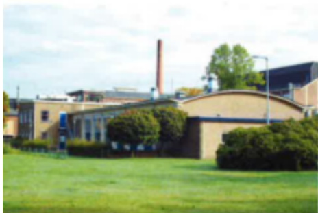
De (inmiddels) gesloopte kantine van het Philipscomplex
