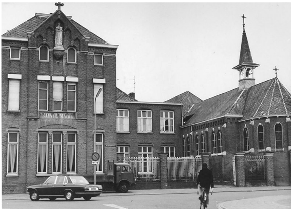
Zicht vanuit de Dominéstraat anno 1975
