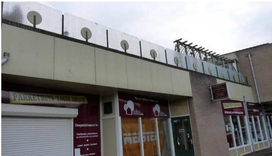
De huidige situatie van de bestaande bebouwing Burgerhoutsestraat 45A.
