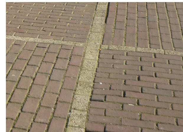
Hergebruik van de gebakken klinkers van het bestaande plein.
