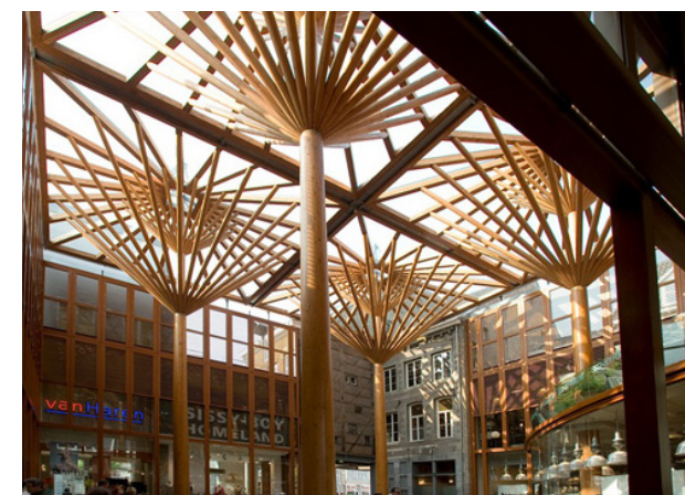
De kap van de huiskamer wordt geschaagd door een monumentale houten boomconstructie.
