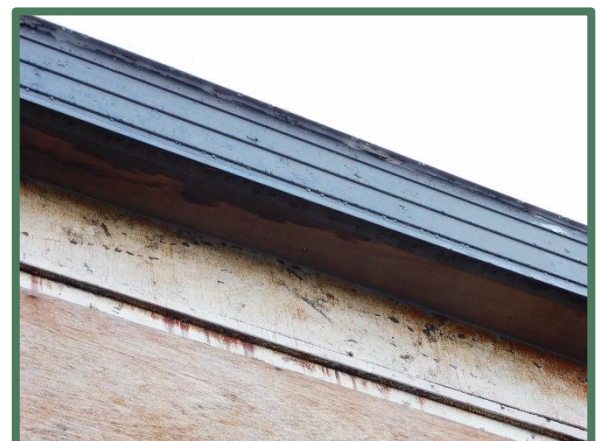
Aansluitende houten boeiboord boven kozijn
