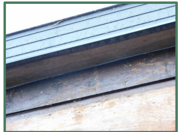
Aansluitende houten boeiboord boven kozijn
