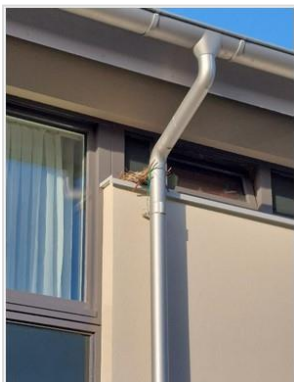
Figuur 5.1 Nest achter regenpijp aan Genestetlaan 12.
