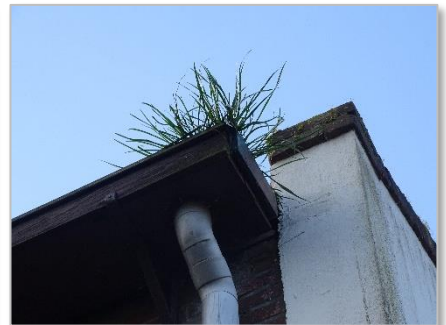
Foto 39: Daken, dakranden en gevels in bebouwing plangebied.
