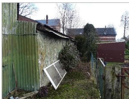
Foto 14: Schuren achter bebouwing plangebied Roosendaalsestraat.
