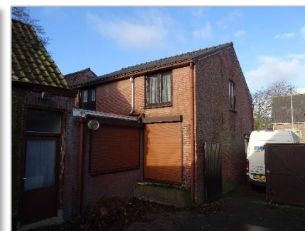
Foto 12: Schuren achter bebouwing plangebied Roosendaalsestraat.
