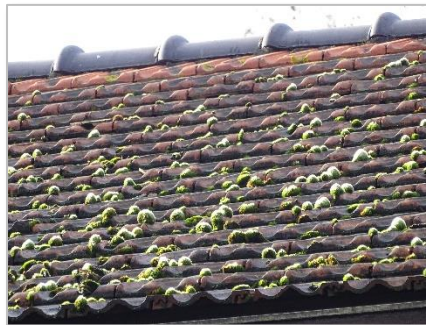
Foto 38: Daken, dakranden en gevels in bebouwing plangebied.
