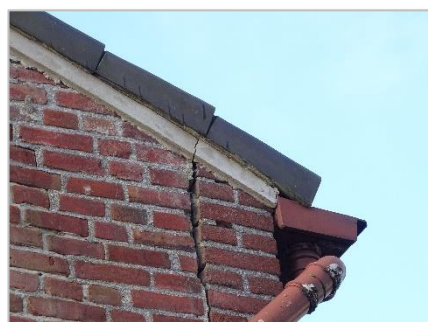
Foto 36: Daken, dakranden en gevels in bebouwing plangebied.
