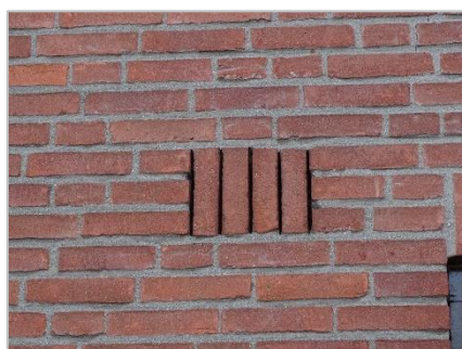
Foto 35: Daken, dakranden en gevels in bebouwing plangebied.
