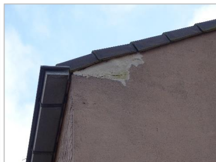
Foto 33: Daken, dakranden en gevels in bebouwing plangebied.
