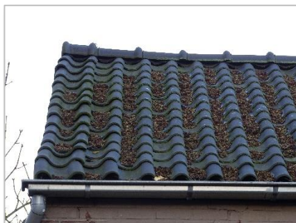
Foto 31: Daken, dakranden en gevels in bebouwing plangebied.
