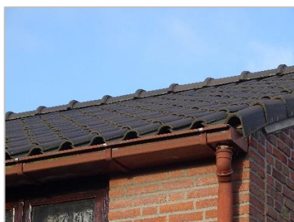
Foto 34: Daken, dakranden en gevels in bebouwing plangebied.
