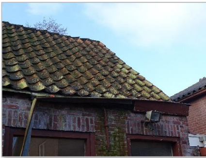
Foto 37: Daken, dakranden en gevels in bebouwing plangebied.
