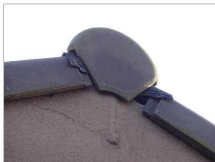
Foto 32: Daken, dakranden en gevels in bebouwing plangebied.
