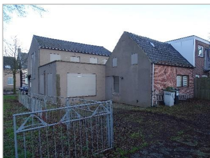
Foto 10: Schuren achter bebouwing plangebied Roosendaalsestraat.
