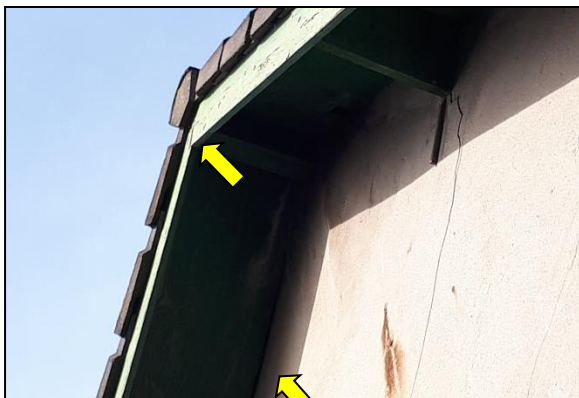
Figuur 13. Ruimte onder dakpannen en achter betimmering geschikt voor vleermuis.
