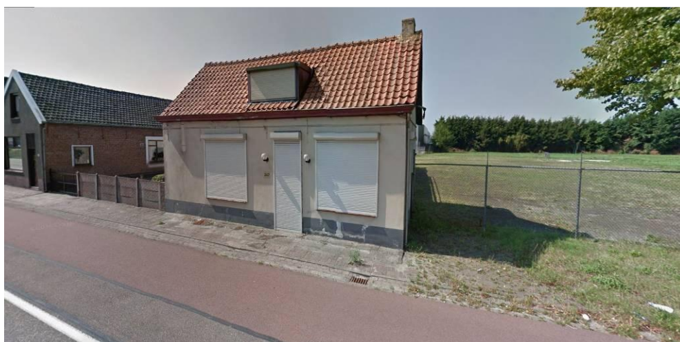
Figuur 4 - Voormalige, inmiddels gesloopte, bedrijfswoning in het plangebied, gezien vanaf de Gastelseweg (bron: Google Streetview, augustus 2015); inks is de voormalige woning Gastelseweg 245 te zien; rechts is een deel van het plangebied (thans nog onbebouwd) te zien.
