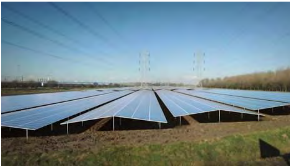
Figuur 6: impressie oost-west opstelling zonnepanelen
