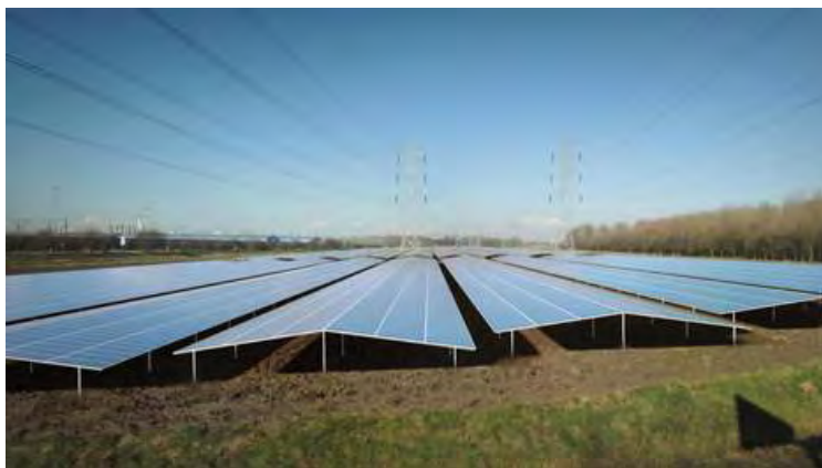
Figuur 2.4: impressie oost-west opstelling zonnepanelen (Bron: DIEPP)
