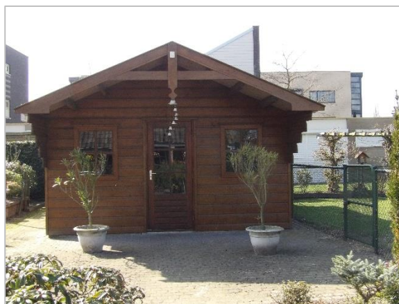
Foto 4: Blokhut/Tuinhuis Heerma van Vossstraat 38 te Roosendaal.
