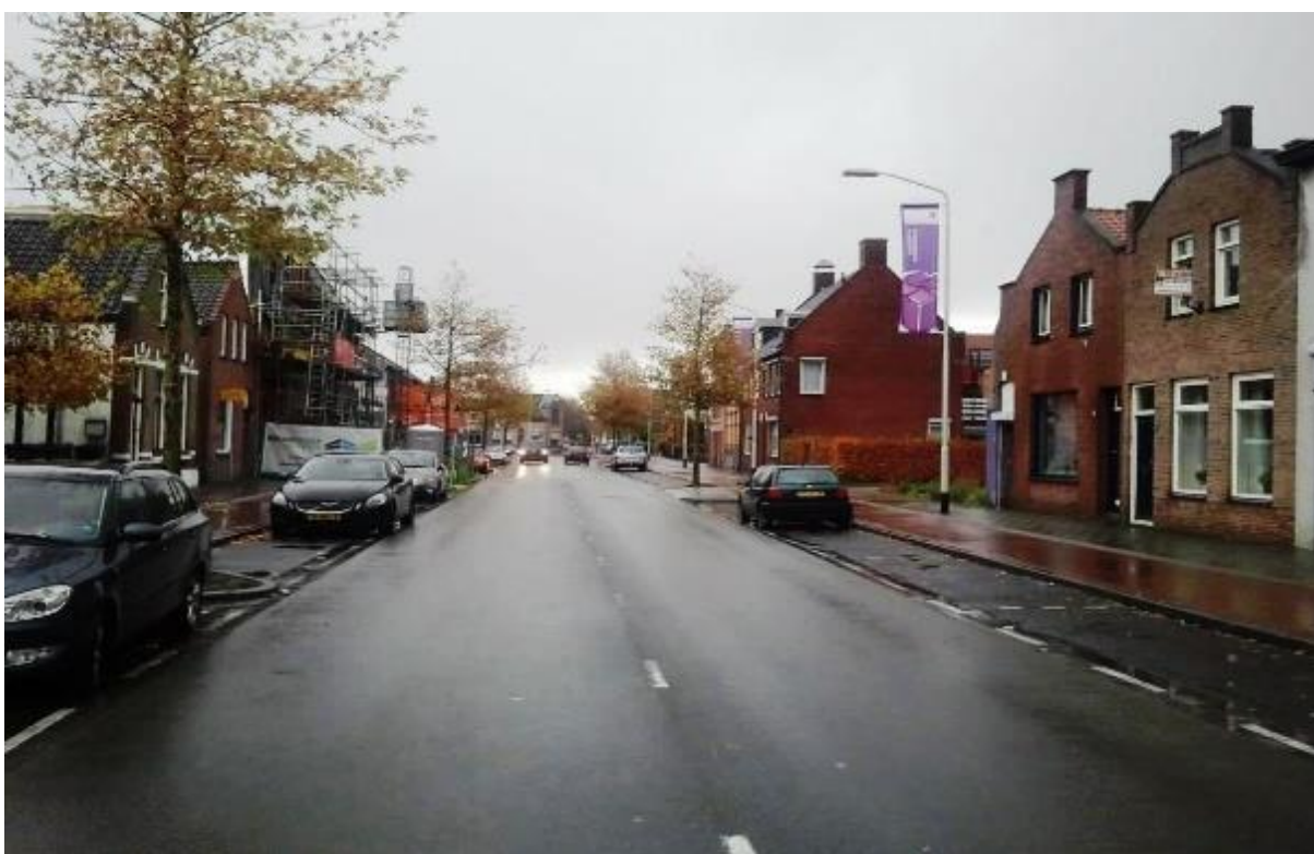
Figuur 8: Zicht na sloop
