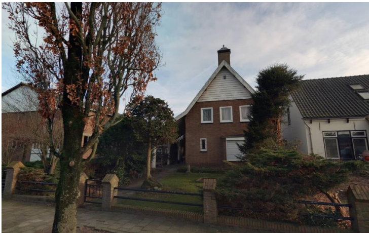
Huidige situatie (bedrijfsloods en bedrijfswoning)
