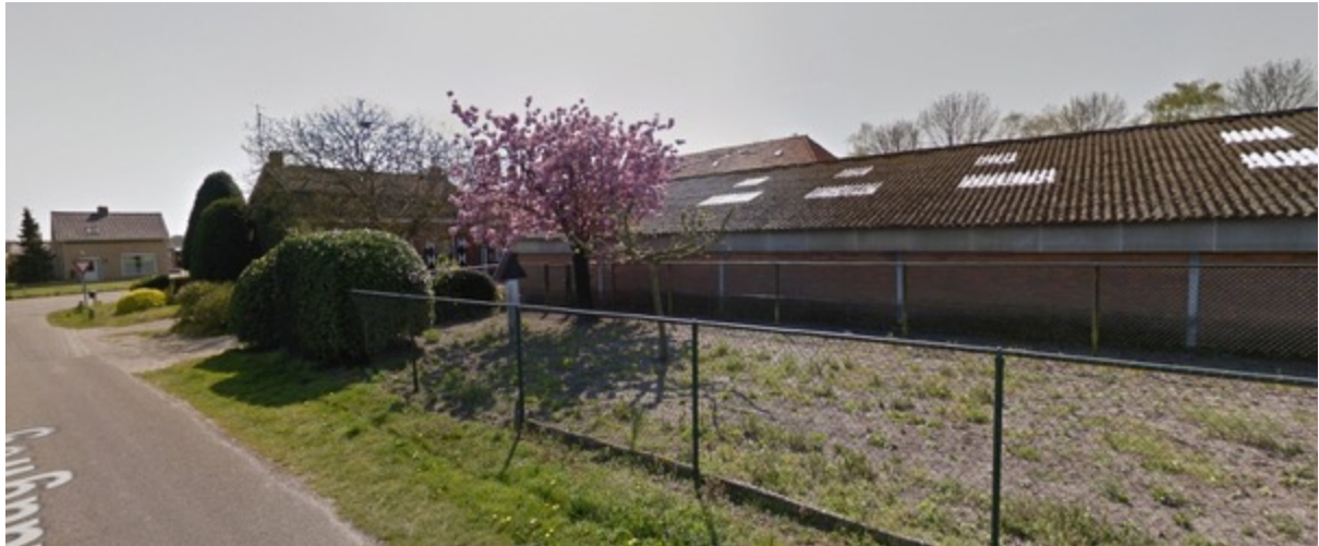
Foto met zicht op voormalige agrarische stal (rechts) en bestaande woning (midden/links) vanuit Laagweg gezien; bron: GoogleMaps
