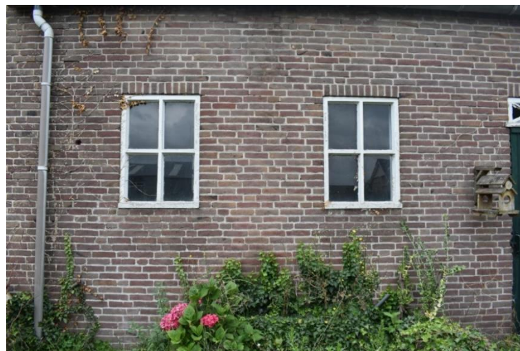
Betonnen stalvensters in voorgevel tussenlid.
