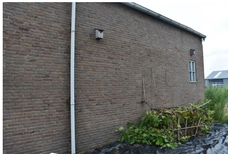
Uiterst rechts in linkerzijgevel een betonnen stalvenster.
