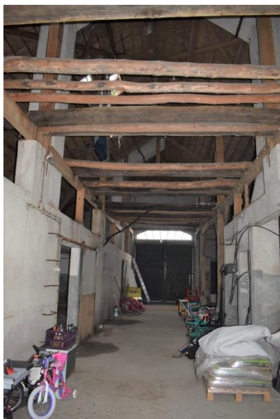
Zicht richting deuren in voorgevel.
