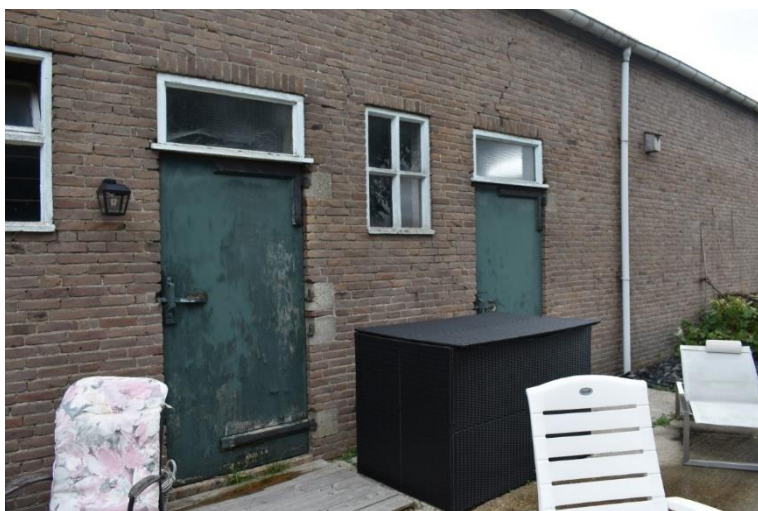
Vernieuwde paardenstal deuren in linkerzijgevel.
