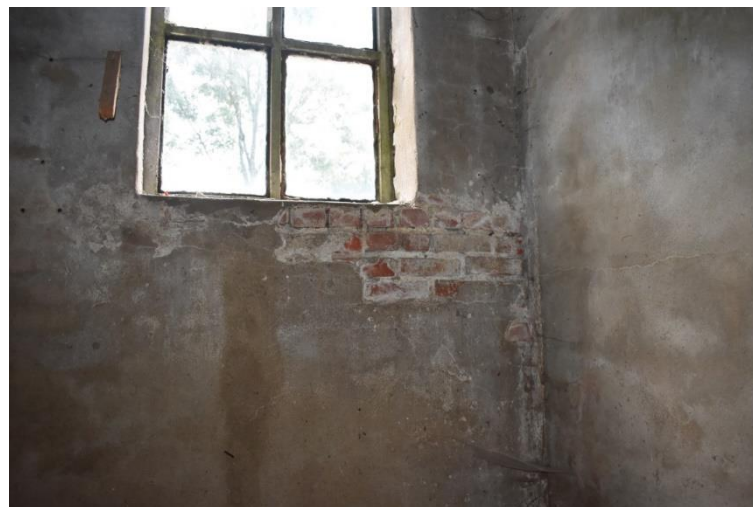
Binnenspouwblad van rode baksteen in kruisverband.
