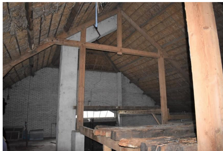
Nokstijlspant dat het dak draagt.
