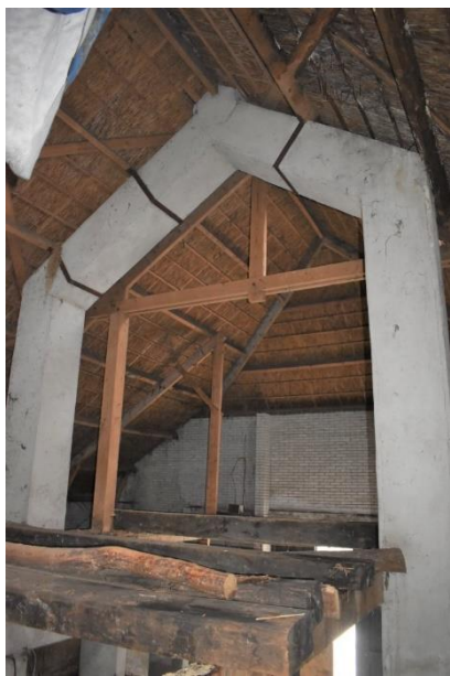
De betonnen ventilatiekanalen.
