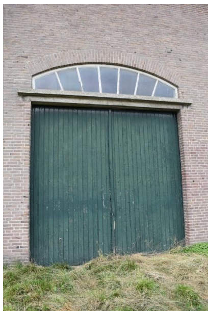
Langsdeeldeuren in schuur.
