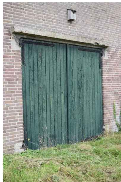
Dubbele staldeur in schuur.
