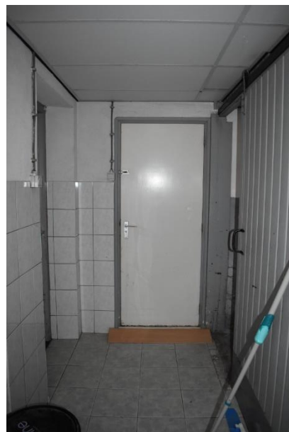
Toilet op oorspronkelijke locatie.
