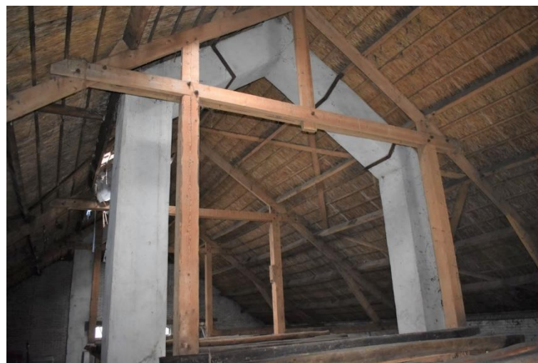
Nokstijlspant met daarachter de betonnen ventilatiekanalen.
