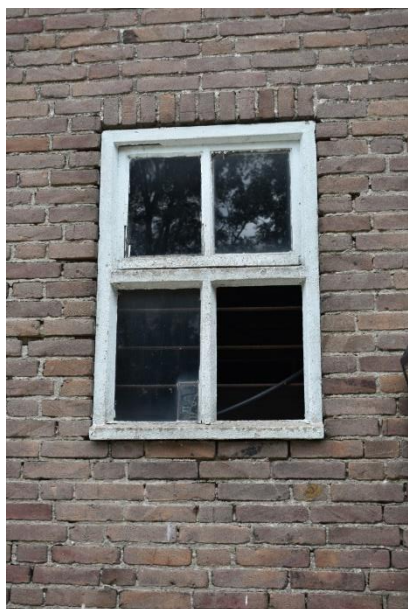
Betonnen stalvenster.
