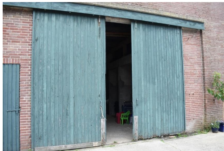
Oorspronkelijke schuivende langsdeelsdeuren in achtergevel.
