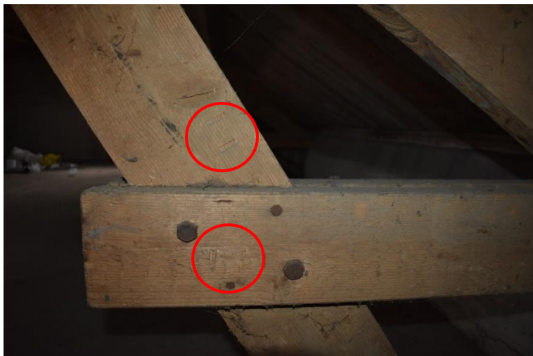
Telmerken II in spant boven het tussenlid.
