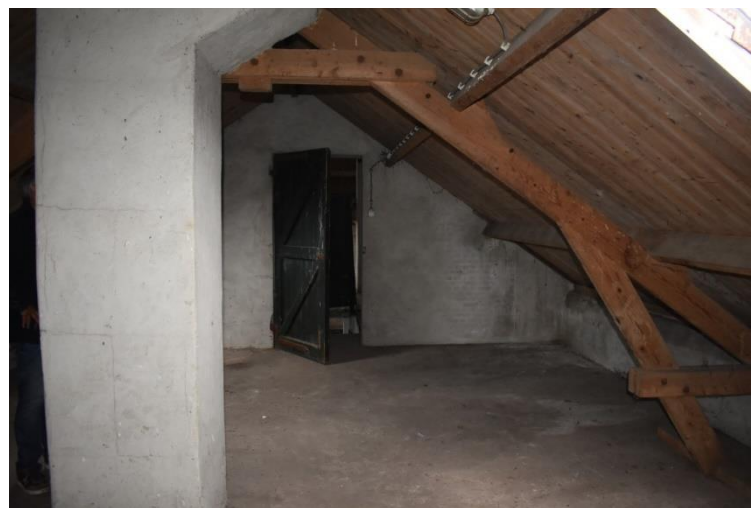
Zolder boven tussenlid, oorspronkelijk de graanzolder.
