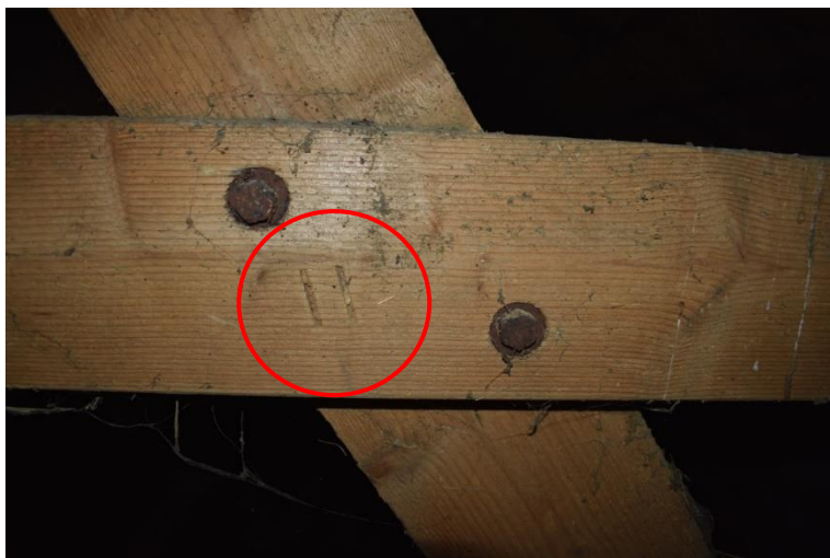
Telmerk II in het tweede spant.
