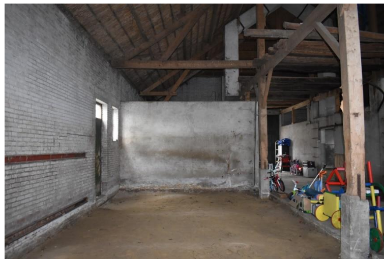
Tasruimte gezien richting het noordwesten.
