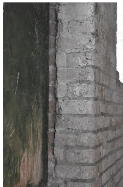
Binnenblad van cementsteen.
