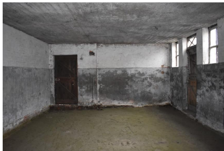
Veestallen gezien richting het noordwesten.
