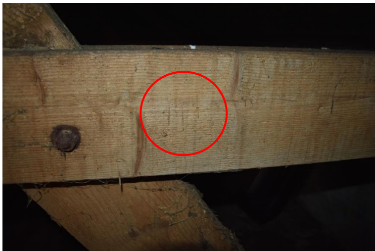
Telmerk III in het derde spant.
