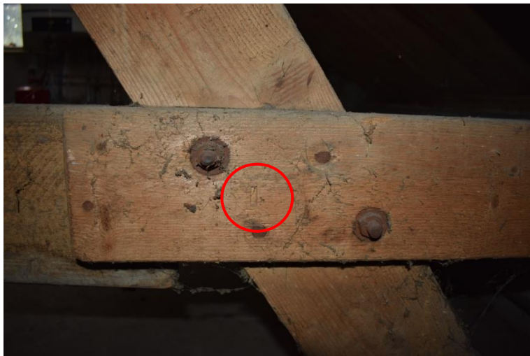
Telmerk I in spant boven het tussenlid.
