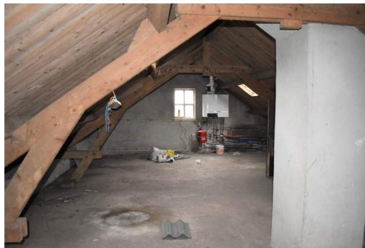
Zolder boven tussenlid, oorspronkelijk de graanzolder.
