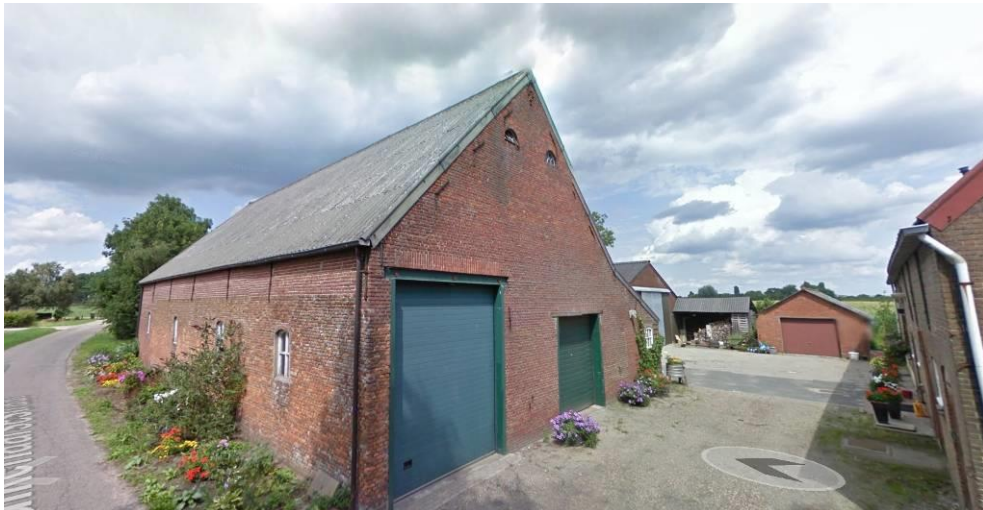
Afbeelding 12 - De voormalige agrarische bedrijfsgebouwen bij boerderij plandeel D (Huijbergseweg 34) liggen achter de voormalige bedrijfswoning. De schuur vooraan is een traditionele zg. Vlaamse schuur met langsdeel en houten gebinten.
