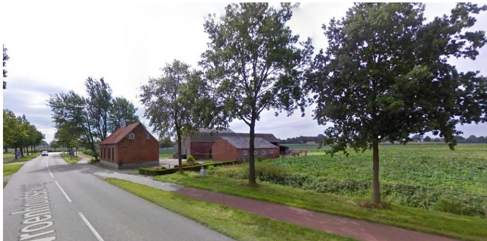
Afbeelding 7 - De voormalige boerderij plandeel B (Vroenhoutseweg 9) - de voormalige agrarische bedrijfswoning staat vrij dicht tegen de Vroenhoutseweg aan; het betreffende gebouw zal worden afgebroken, waardoor er ruimte ontstaat voor het rechte trekken van het fietspad.
