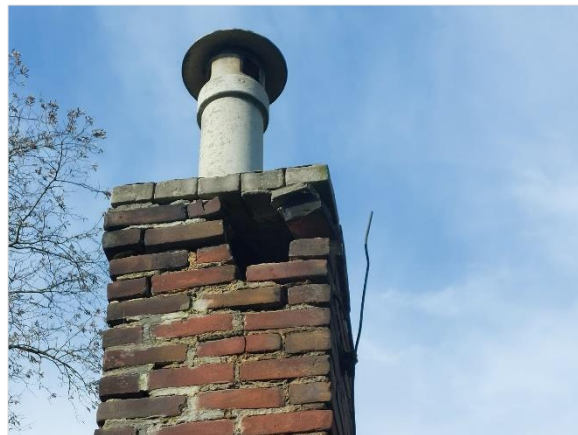
Figuur 4.2 Opening in de schoorsteen van de onderzoekslocatie.
