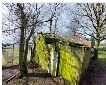
Figuur 2.8 Uitzicht op opstal C, de kas (F) met daarachter het woonhuis (A) (kijkrichting: west).
