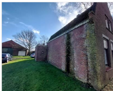
Figuur 2.4 Zijaanzicht op het woonhuis (A) (kijkrichting: zuid-oost).
