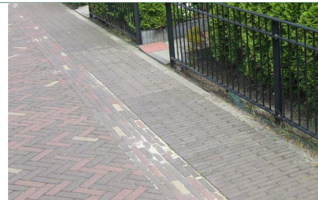
2. Suggestiestroken in wegverharding worden aangeduid door verband (halfsteens) anders dan verband rijstrook (keper). Tevens wordt voor de loopstroken alleen één kleur klinker gebruikt.
