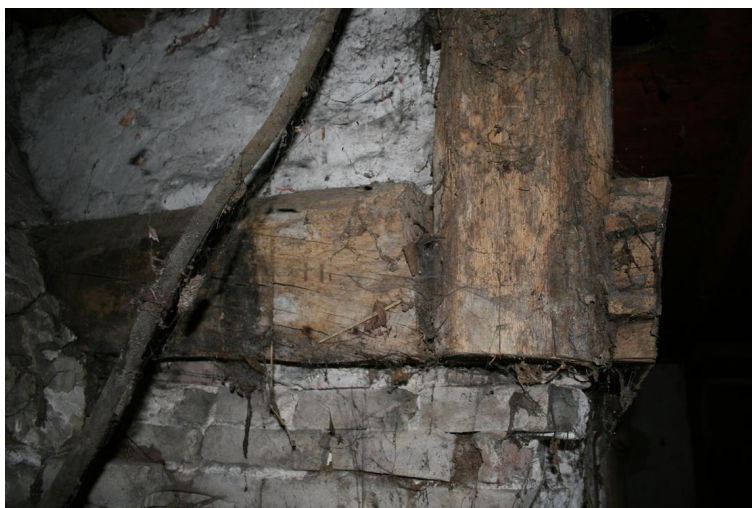
Ankerbalkgebint ter hoogte van de schouw
