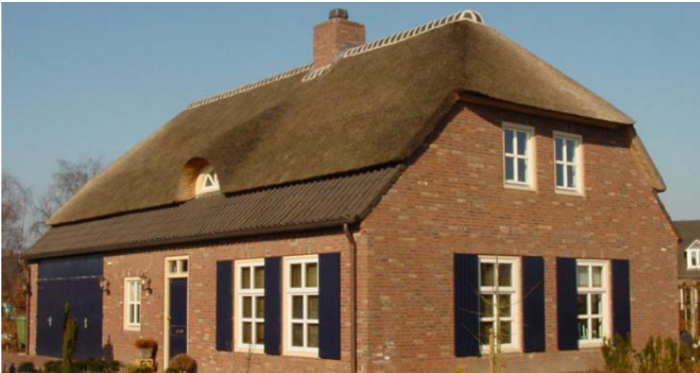
passende detasilleringen dakkapel voorgevel, dakranden, en goot.
