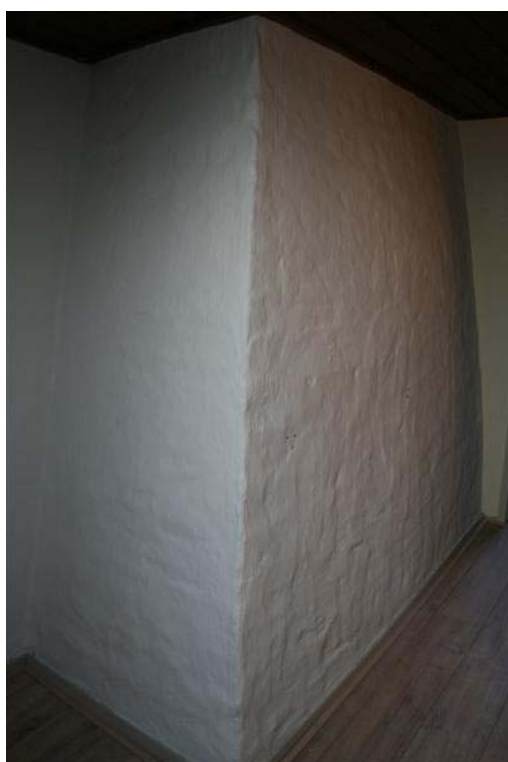
Schouw op de verdieping
