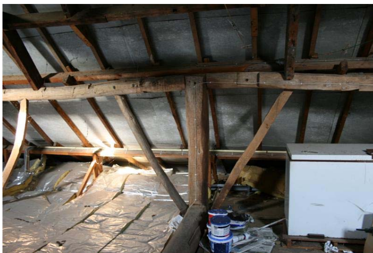
Ankerbalkgebint op de zolder van het voormalige bedrijfsgebouw
