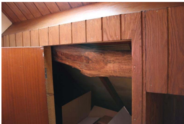
Gebintplaat op de verdieping van het voorhuis
