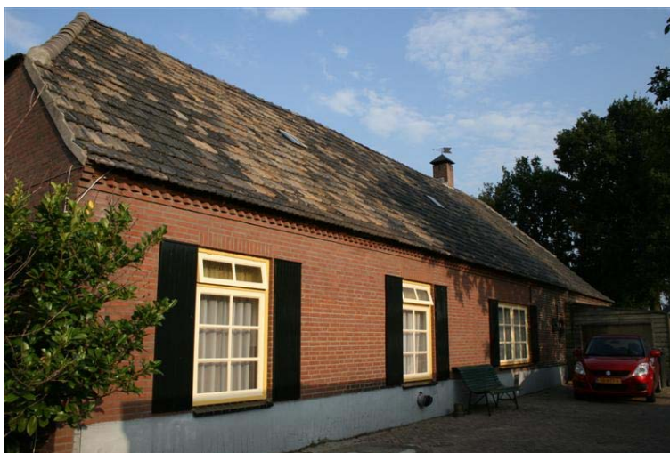
Vernieuwd gedeelte linkerzijgevel
