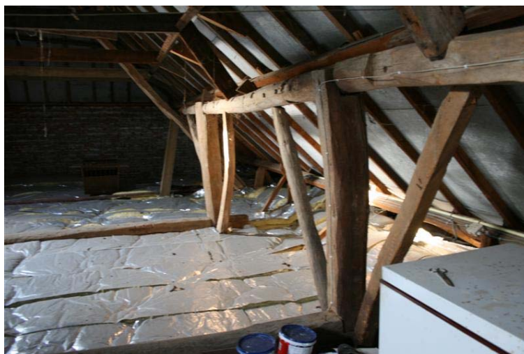
Gebintplaat richting de achtergevel
