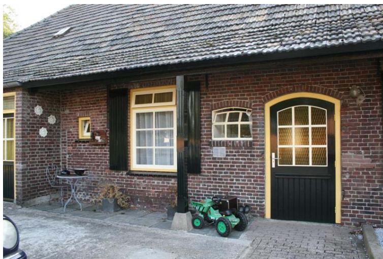
Oorspronkelijk gedeelte rechterzijgevel
