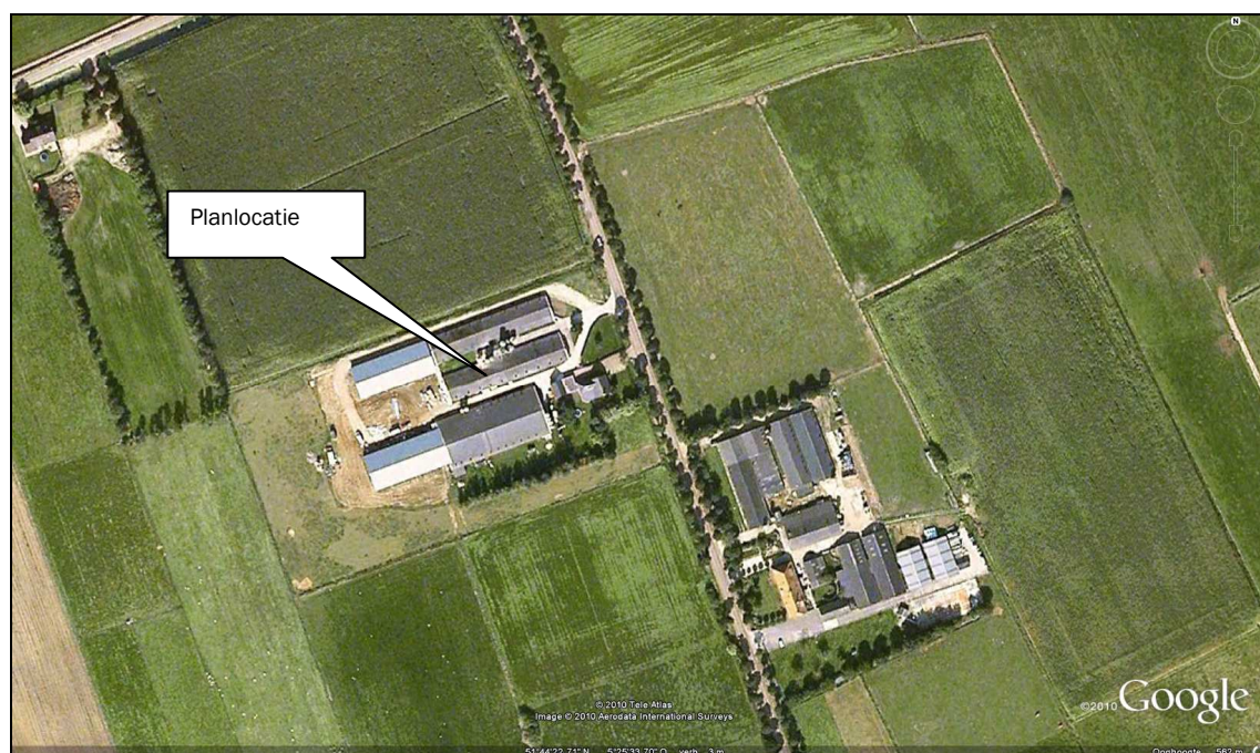
Figuur 2: luchtfoto planlocatie
