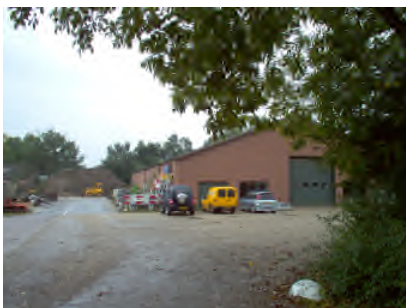
Stenen hal en romneyloods
