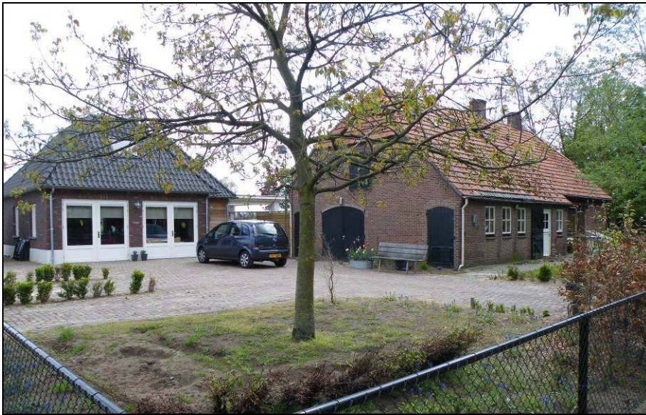
Ligging bestaande woning Papendijk 10
