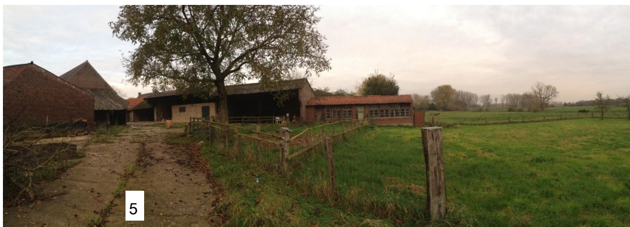
Figuur 2.4 Bestaande situatie, het erf in beeld.
