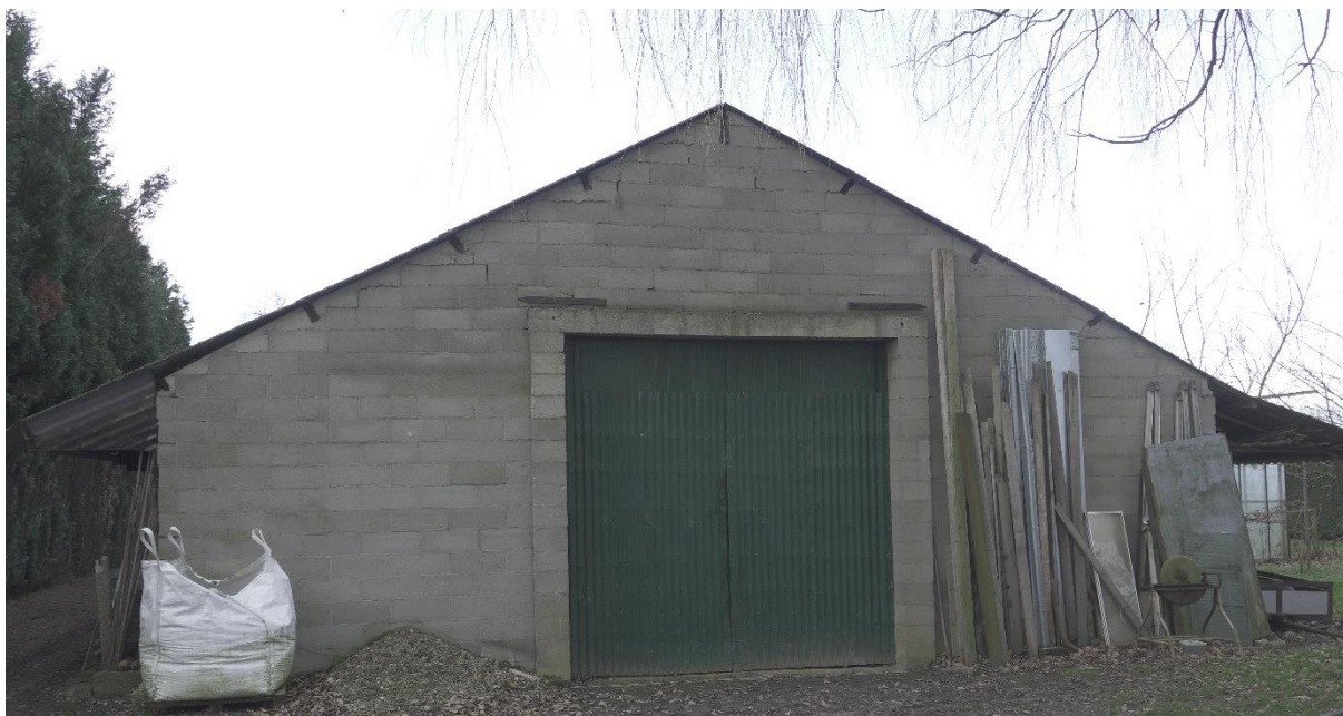
De oude landbouwloods wordt gesloopt.
