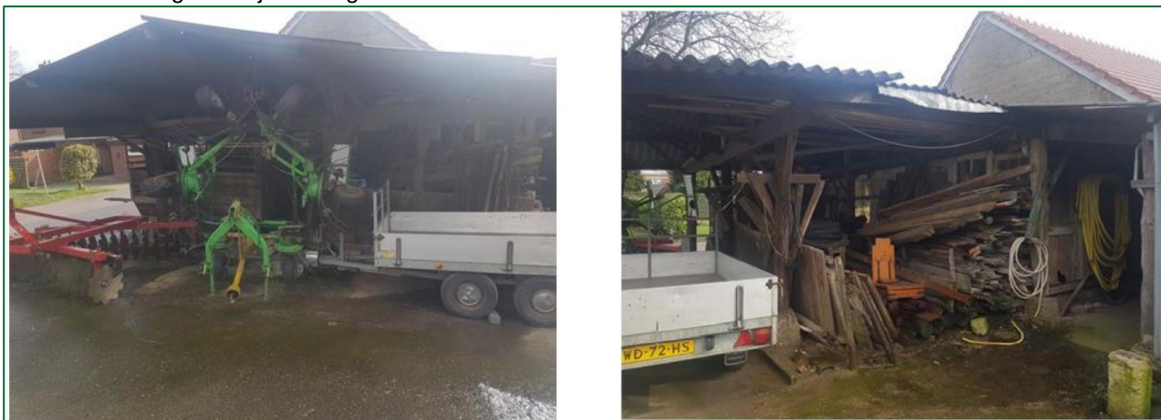
Figuur 2.1.1: Aanzicht te slopen bedrijfsgebouw; aanbouw aan voormalige bedrijfswoning
