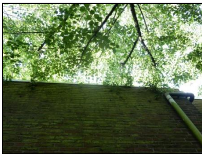
Figuur 3. Open stootvoegen naar de spouwmuur.
