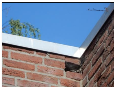
Figuur 7. Open ruimtes in de gevel en tussen de daklijst.
