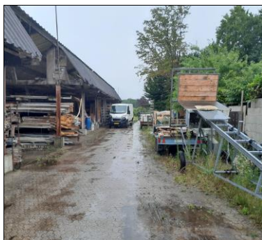
Loods achter de bedrijfswoning
