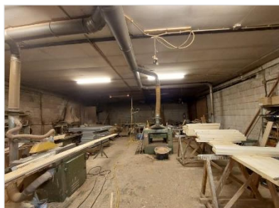
Figuur 2.4 Binnenzijde noordelijke opstal.
