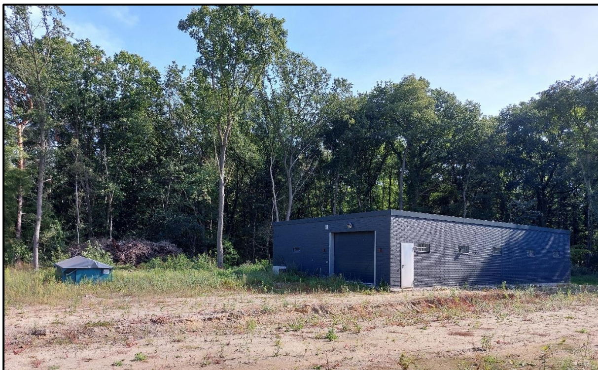
Figuur 4.1 situatie privé opslag; er is sprake van een massief gebouw dat geen ruimte biedt aan verblijfplaatsen voor vleermuizen.
