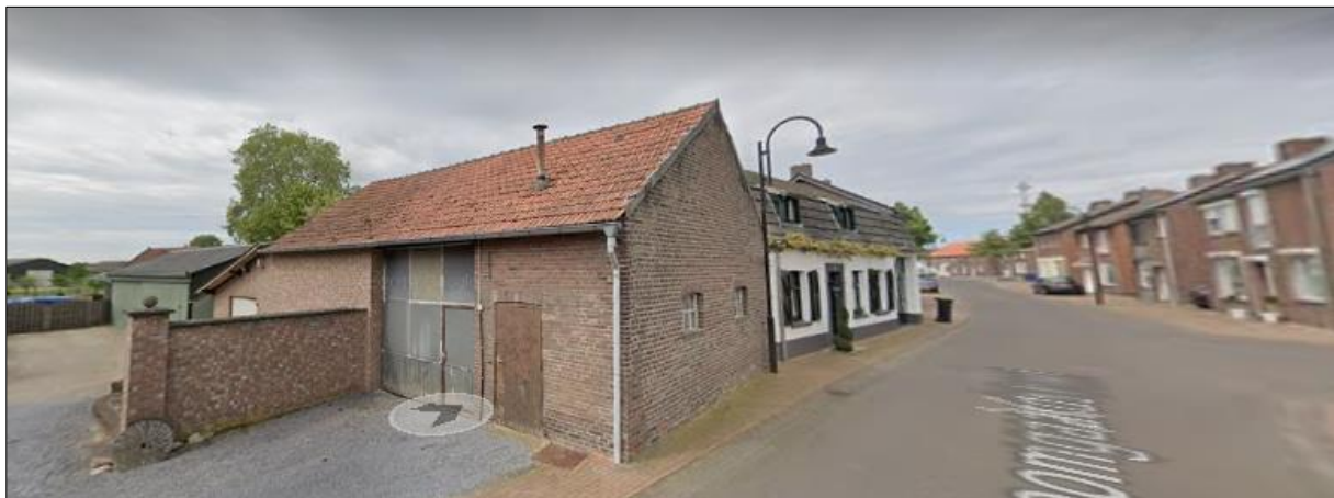
Afbeelding 12: Voorzijde plangebied te slopen schuur
