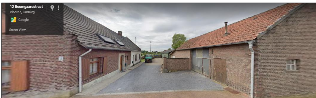
Afbeelding 4: Zicht op te slopen schuur en woning Boomgaardstraat 12
