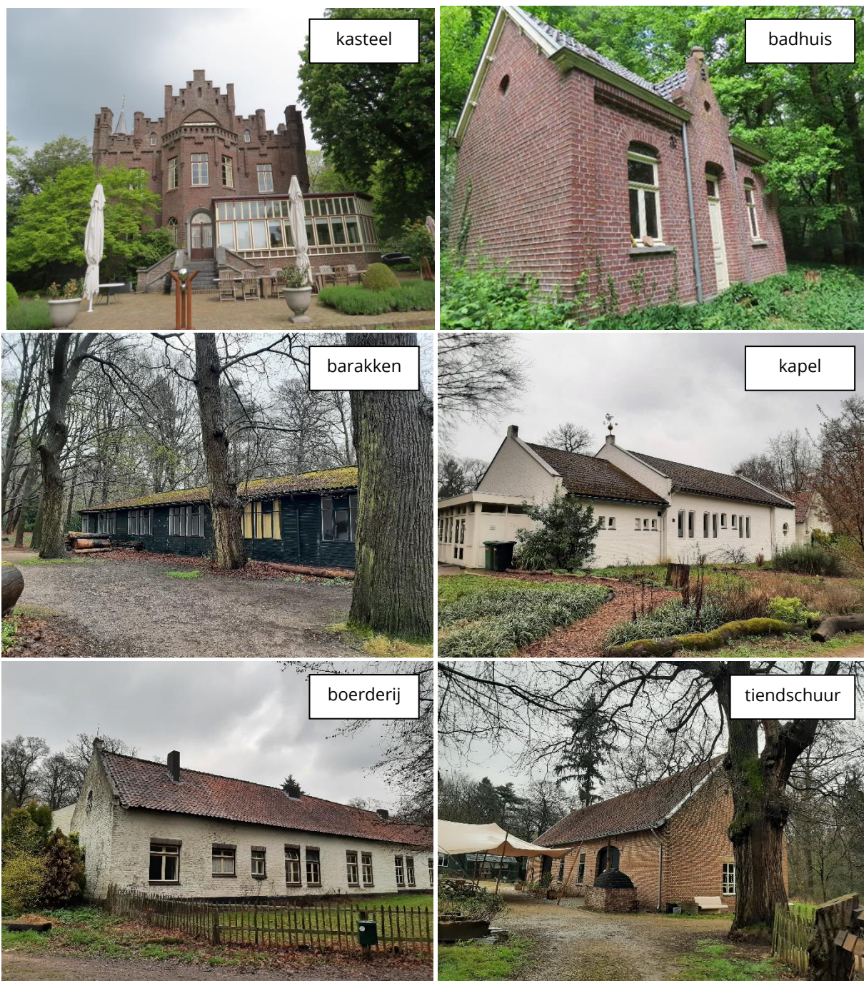
Afbeelding 2.2: Foto's bestaande situatie (April 2022)
