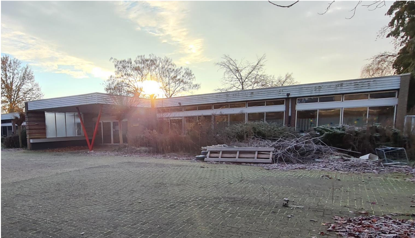
Figuur 4: Leegstaand schoolgebouw in het noorden van het plangebied
