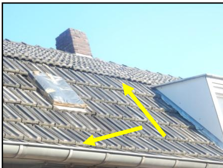
Figuur 9. Ruimte tussen of onder de dakpannen die toegang verleent tot geschikte nestlocaties tussen het dak en het dakbeschoot.
