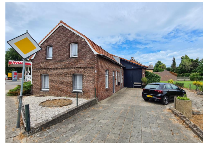
Figuur 4: Woning gezien vanaf de Huysbongerdweg
