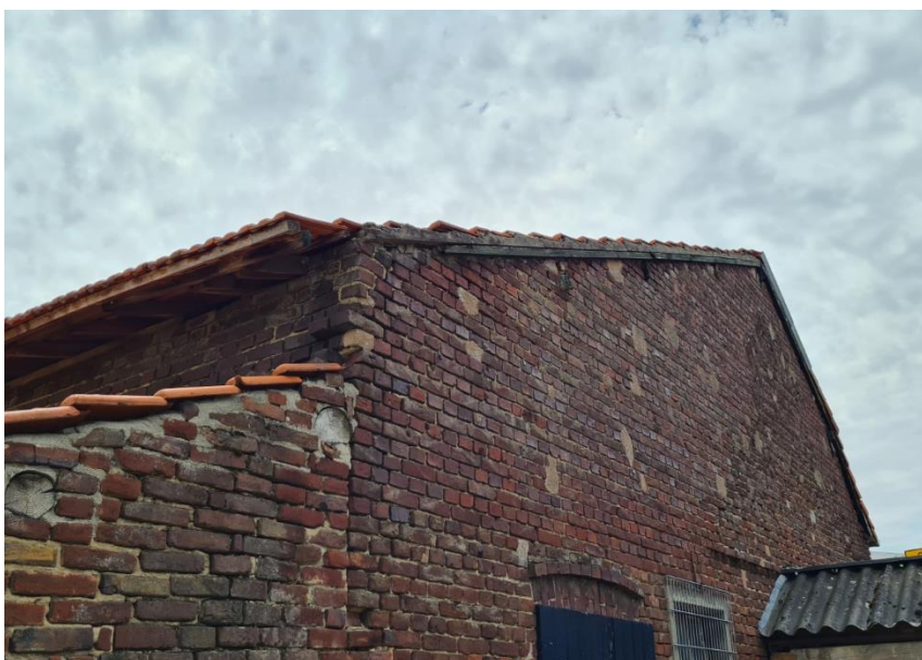
Figuur 5: Detail van de gevel van de schuur aan de woning
