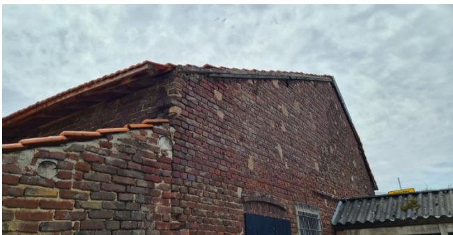
Figuur 7: Detail van de gevel van de schuur aan de woning
