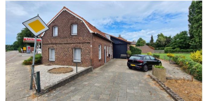
Figuur 5: Woning gezien vanaf de Huysbongerdweg
