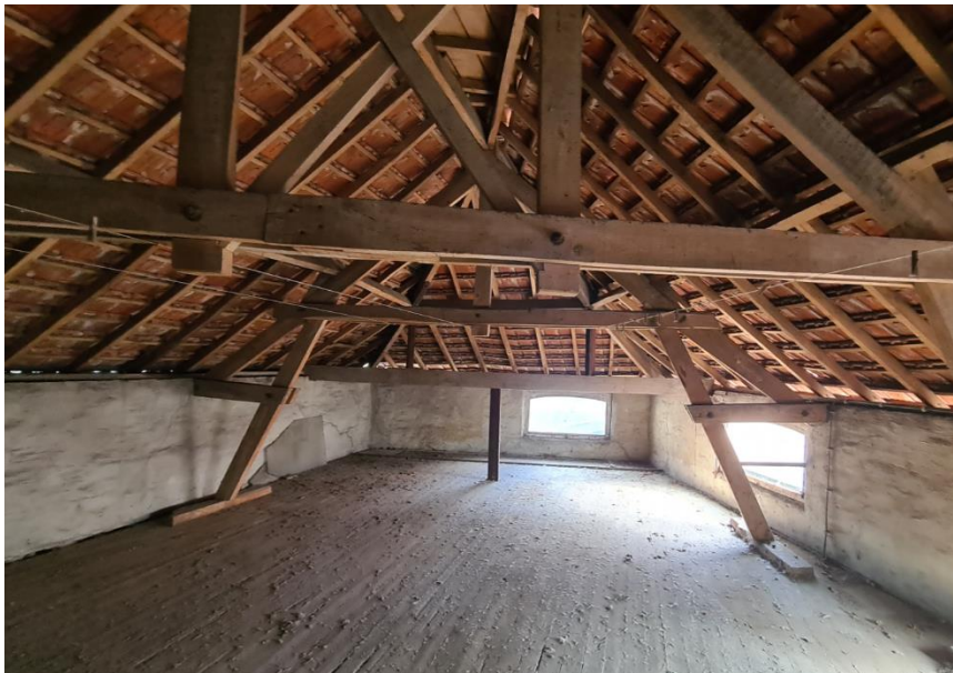
Figuur 6: Zolderruimte van de stal ten westen van de woning
