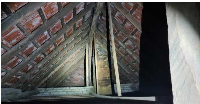
Figuur 7: Zolderruimte van de woonboerderij
