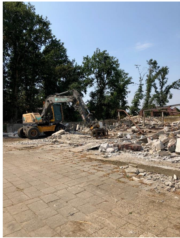
Het puin is afgevoerd.
