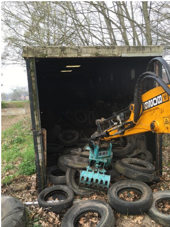
De op het terrein achtergelaten autobanden verwijderen.
