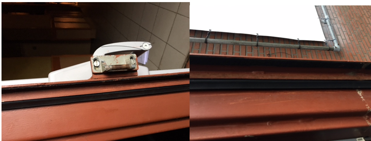
Foto's bestaande situatie kierdichting nooddeur
