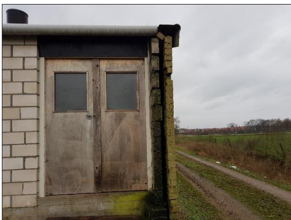
Figuur 14. Open spouwmuur in noordzijde stallencomplex (plangebied 1)
