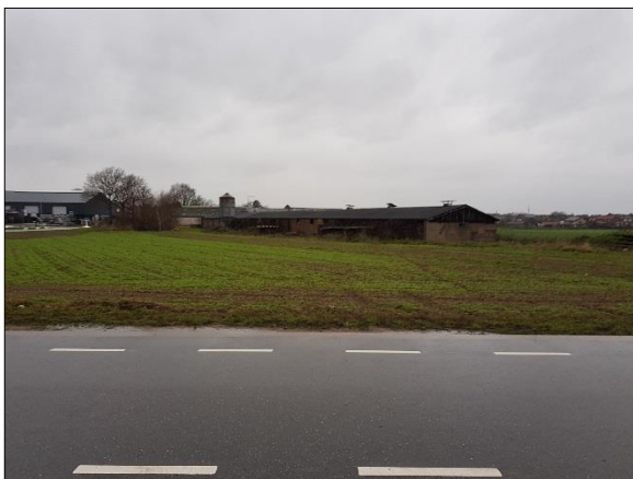
Figuur 7. Vervallen kippenstal en grond in westelijk plangebied (plangebied 2)
