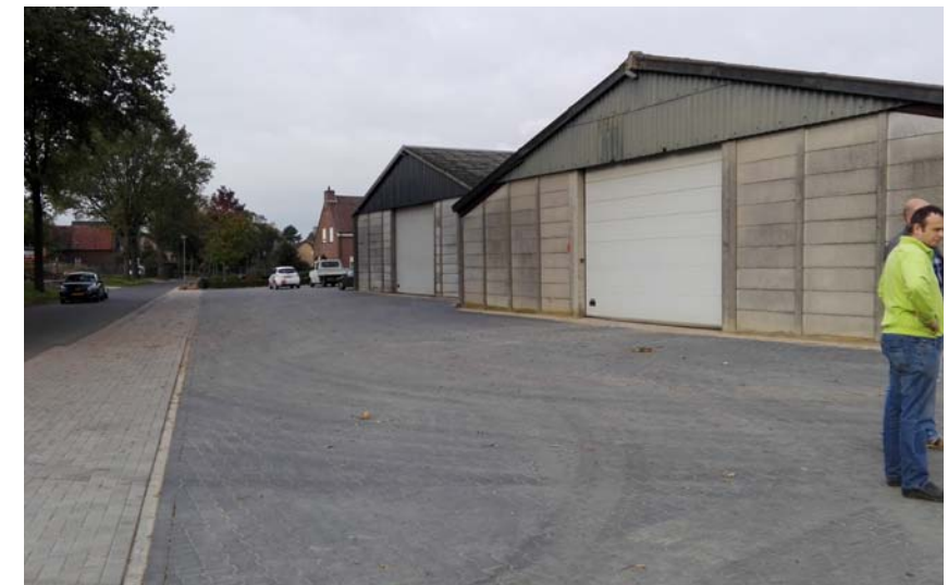
Loonbedrijf Coenen breidt uit op één van de nieuwe bedrijfskavels. De loods op de voorgrond wordt gesloopt.
