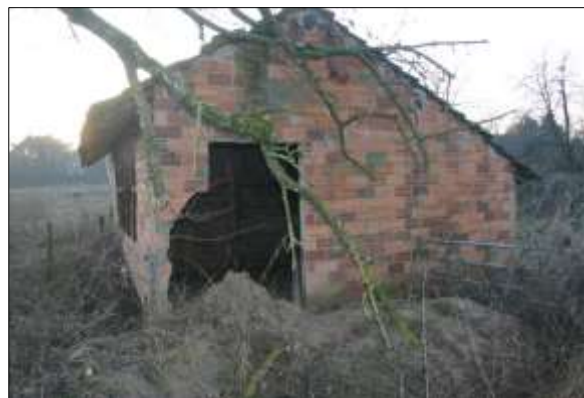
Figuur 11: Te slopen gebouw 5 (alleen bovengronds bron: Aeres Milieu)
