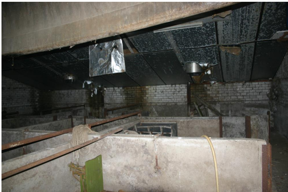
Figuur 4.5.1. Binnenzijde gebouw 9.
