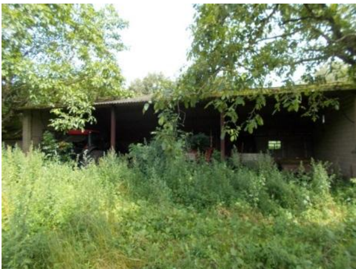
Foto 6: Onderzoekslocatie (machinestalling met asbest-dakplaten)
