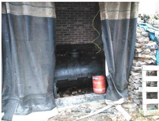
Tank voor afgewerkte olie, in lekbak
