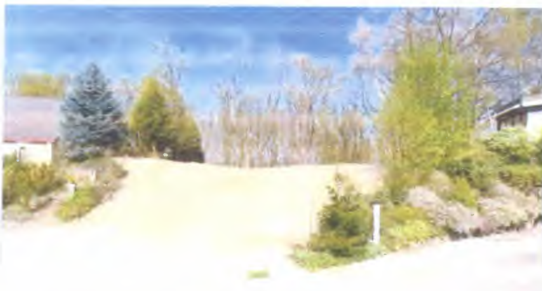
Figuur. Situatie d.d. 12-04-2007; kaalslag na kappen van bomen, afgraven talud, illegale bouw, sloop daarvan en aanbrengen zand.
